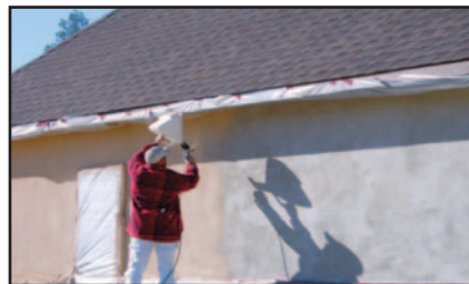
APPLY STUCCO MIX
